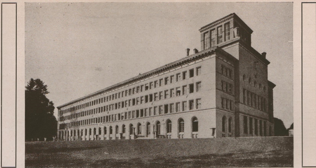
Le nouveau Palais du Bureau international du Travail à Genève
