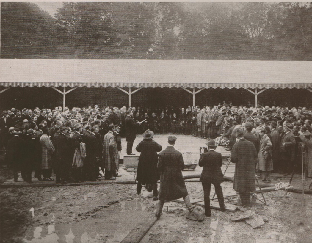
Cérémonie de la pose solennelle de la première pierre du Palais du Bureau international du Travail. Genève 21 octobre 1923
